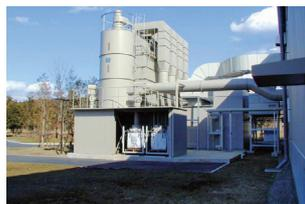
加工の段階で排出される大量の木屑を工場内のダクトで集塵機に集め、「空気」と「木屑」に分別、この「空気」を浄化し、工場内の空調（暖房）に循環利用しています。
